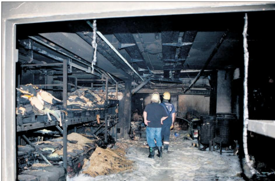
Ein endzeitlich anmutendes Bild der Zerstörung: Blick ins Innere des Bäckerei-Lagers. Die Kellerdecke ist brüchig und ein-sturzgefährdet. Das Gebäude ins-gesamt aber ist nicht irreparabel beschädigt.
