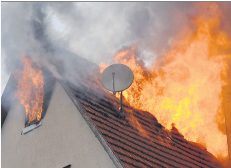
Wahrscheinlich hat das Feuer im Dachstuhl losgelegt. Er brannte komplett aus.
