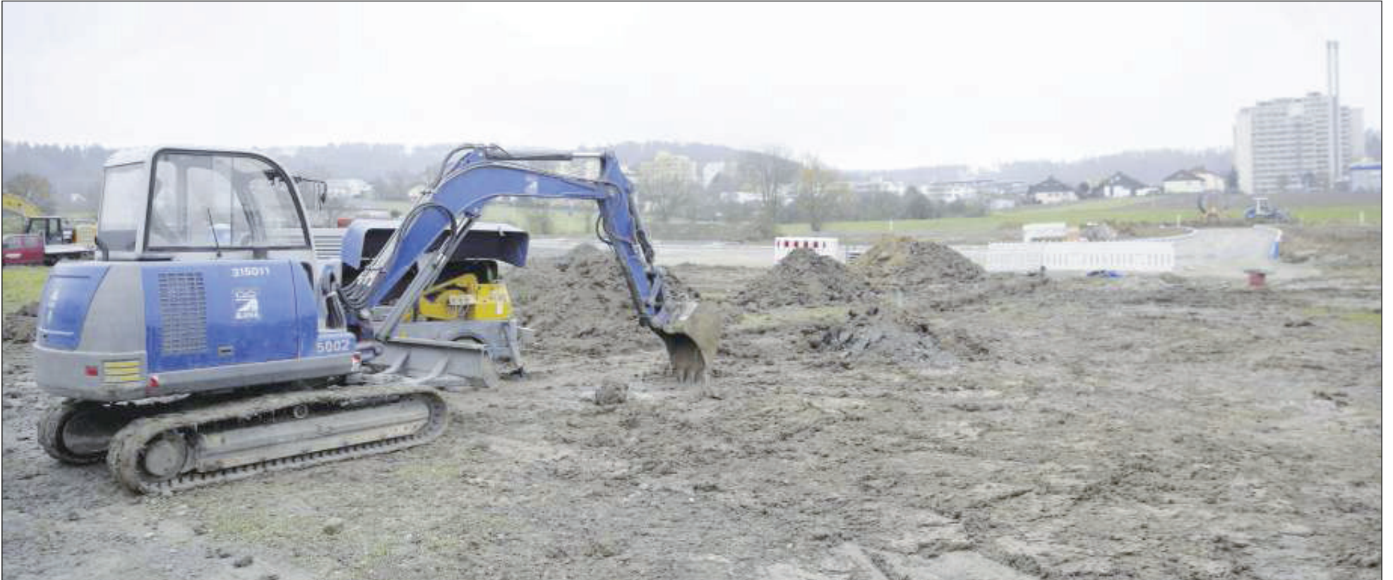
Gleich neben dem Klinik-Kreisel, zwischen Schelmenholz und Zipfelbach, ist der Bauplatz fürs neue Feuerwehrhaus vorbereitet.
